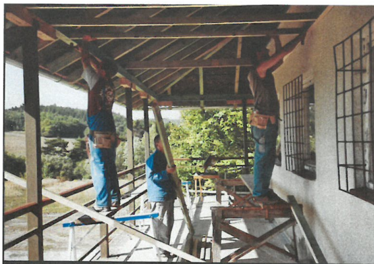
Zastřešení budovy kabin
